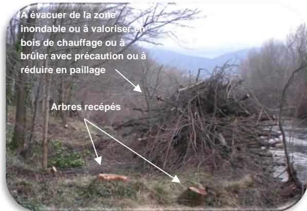
**Enlever les embâcles\*** (branches et troncs d'arbres) qui entravent la circulation de l'eau manuellement ou à l'aide d'un **engin motorisé sur berge** pour les tirer.
