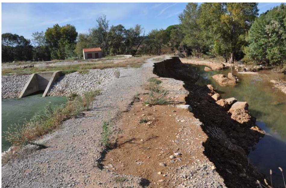
*Le lagunage est l'un des points les plus impactés par les événements pluvieux. Berges effondrées, clôture emportée, bâches affaissées nécessitent des travaux urgents.*
