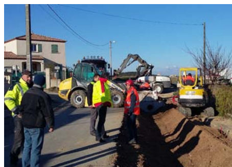
Les travaux ont duré plus de quatre mois et ont nécessité une vingtaine de visites auprès des entreprises et des riverains.
